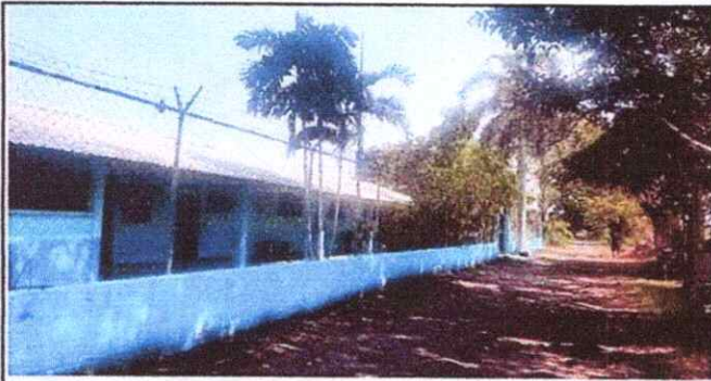
Foto 8: Reparación del muro. 15.2
