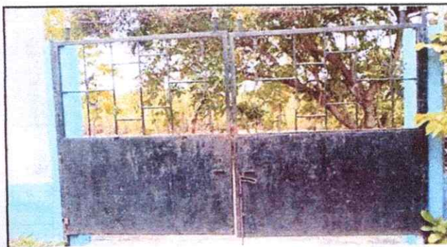
Foto 4: Mantenimiento del portón 4.5
