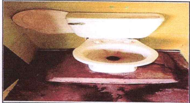
Foto 8: Sustitución de inodoros Renglón 10.3
