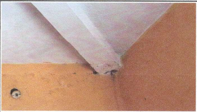
Foto 9: Foto de viga en modulo de gradas.
