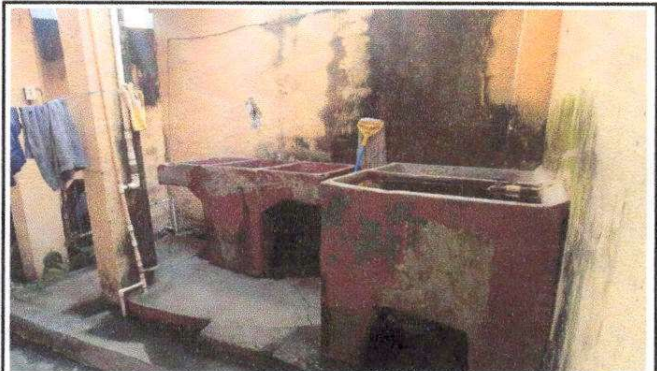
Foto 4: Foto de pilas existentes
