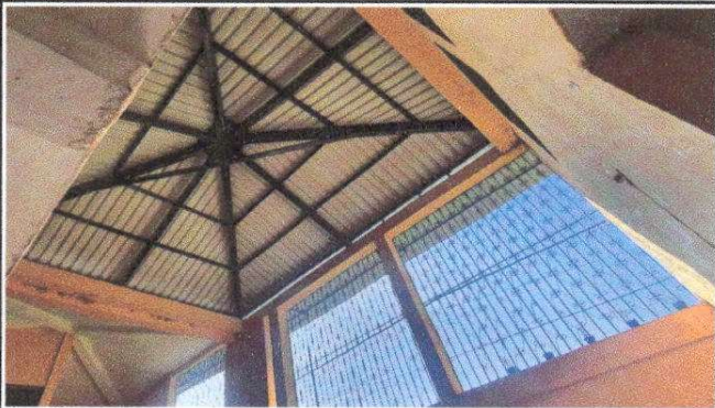
Foto 3: Foto techo de area comun.
