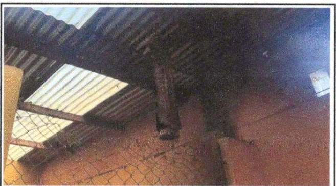
Foto 6: Foto de área para extracción de humo.
