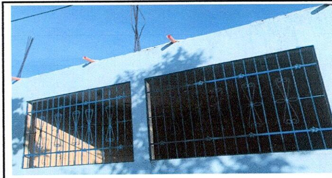
FOTO 6. AULA. 3 5.6 Sustitución de balcones de metal.
