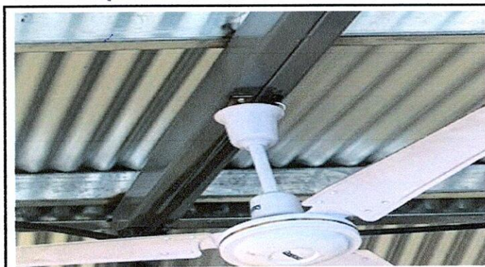
FOTO 3. AULA 4. 2.3 Sustitución de estructura de soporte de metal, por metal.
