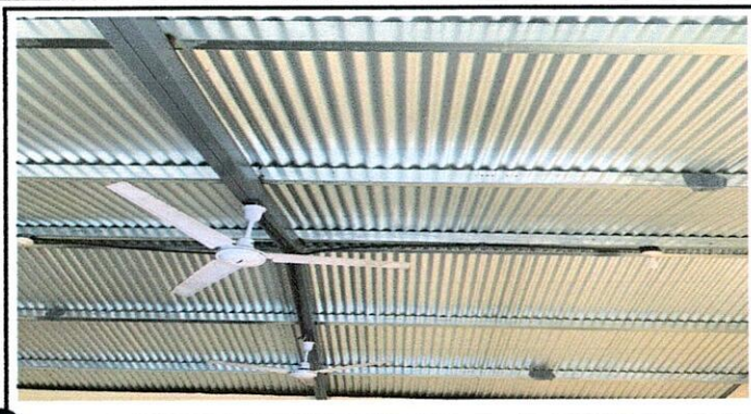
FOTO 1. AULA 4. 1.1 Sustitución de lámina por lámina troquelada alucin calibre 26.
