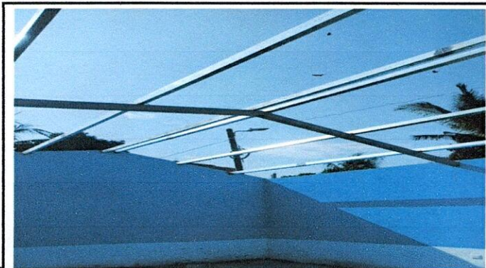
FOTO 1. AULA 4. 1.1 Sustitución de lámina por lámina troquelada alucín calibre 26.
