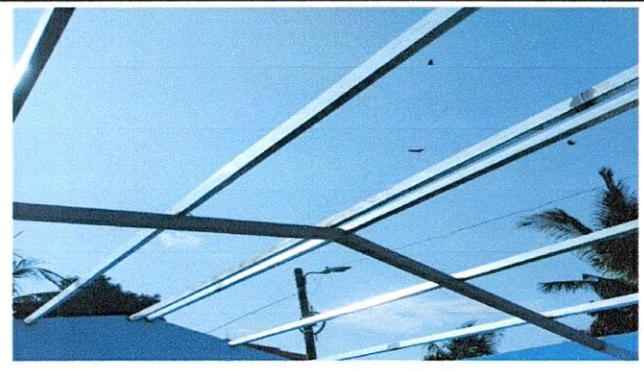
FOTO 2. AULA 4. 1.3 Sustitución de elementos de fijacion
