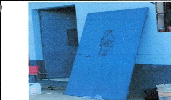
FOTO 5: AULA 4. 4.5 Sustitucion de porton de metal.
