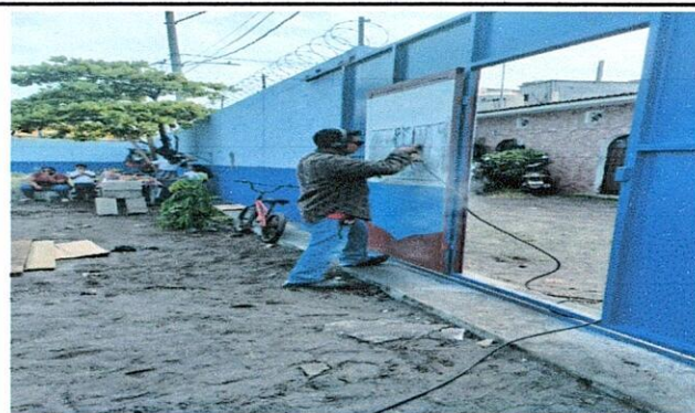
FOTO 4. SANITARIOS 4.1 Mantenimiento a estructura (lijado, cambio de tubo, cepillado, sujecciones, aplicación de pintura.)
