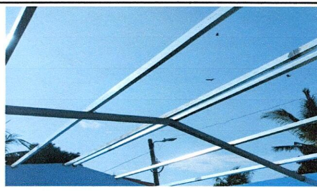
FOTO 2. AULA 4. 1.3 Sustitución de elementos de fijación
