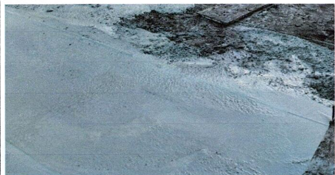
Foto 7: AULA 4. 6.1 Reparacion de piso de torta de concreto.
