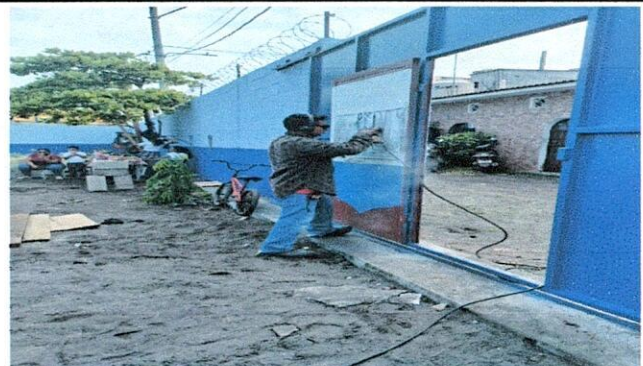
FOTO 4. SANITARIOS 4.1 Mantenimiento a estructura (lijado, cambio de tubo, cepillado, sujecciones, aplicación de pintura.)
