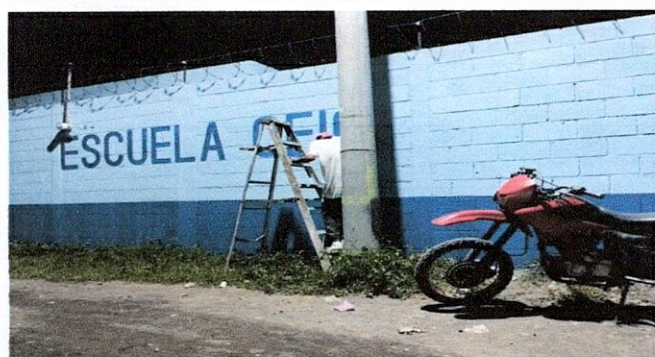
FOTO 9. 9.1 Pintura en muros exteriores e interiores.
