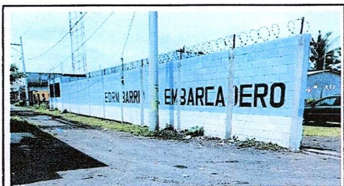
FOTO 9. 9.1 Pintura en muros exteriores e interiores.
