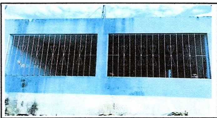
FOTO 6. AULA 3 5.6 Sustitución de balcones de metal.
