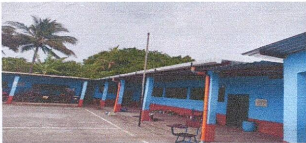
Foto 3: Canal en mal estado, Region 7.1 (Sustitución de canal de metal).
