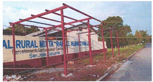
Foto 2: 2.3 SUSTITUCIÓN DE ESTRUCTURA DE SOPORTE DE METAL POR METAL
