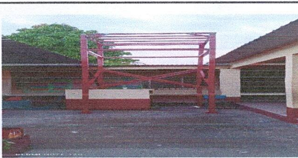
Foto 5: 18.3 SUSTITUCIÓN DE DEPÓSITO DE AGUA 1700 LT
