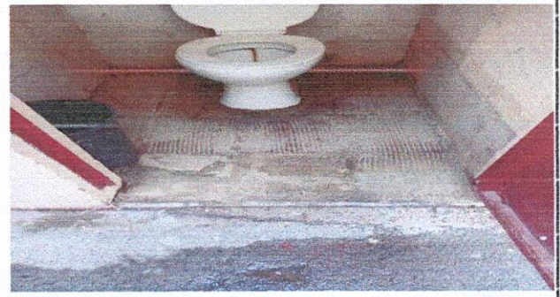
Foto 4: 4.3 SUSTITUCIÓN DE AZULEJO
