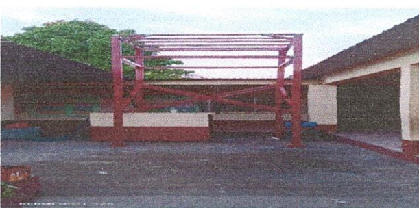
Foto 5: 18.3 SUSTITUCIÓN DE DEPÓSITO DE AGUA 1700 LT
