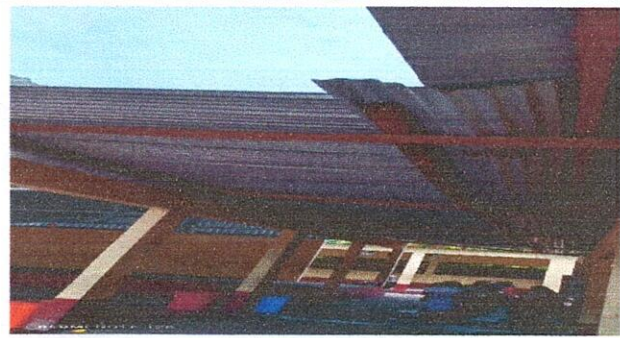
Foto 3: 7.1 SUSTITUCIÓN DE CANAL DE METAL
