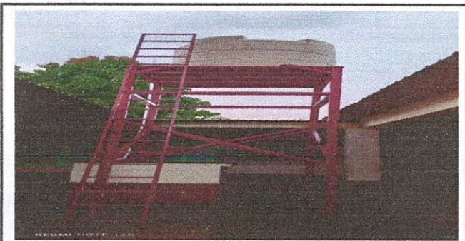
Foto 5: 18.3 SUSTITUCIÓN DE DEPÓSITO DE AGUA 1700 LT
