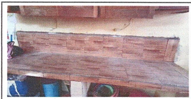
Foto 6: 20.8 REPARACIÓN DE AZULEJO DE COCINA
