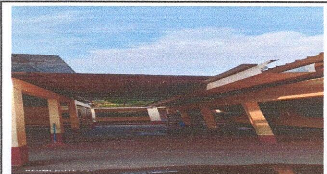
Foto 3: 4.2 SUSTITUCIÓN DE CANAL DE METAL
