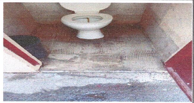
Foto 4: 4.3 SUSTITUCIÓN DE AZULEJO
