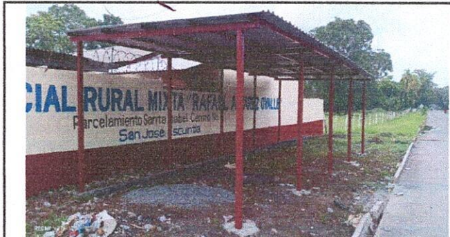
Foto 2: 2.3 SUSTITUCIÓN DE ESTRUCTURA DE SOPORTE DE METAL POR METAL
