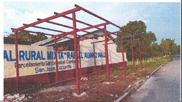
Foto 2: 2.3 SUSTITUCIÓN DE ESTRUCTURA DE SOPORTE DE METAL POR METAL
