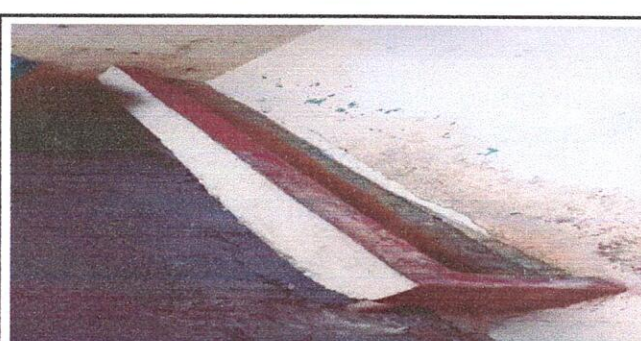
Foto 6: 14.1 MANTENIMIENTO DE REPOSADERAS
