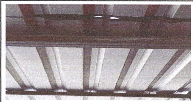
Foto 1: SUSTITUCIÓN DE LÁMINA 1.1
