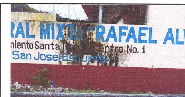
Foto 5: PINTURA DE MURO DE EXTERIORES E INTERIORES 9.1
