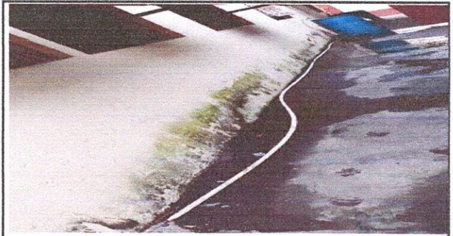
FOTO 8: 14.9 SUSTITUCION DE TUBERIA INEA PRINCIPAL
