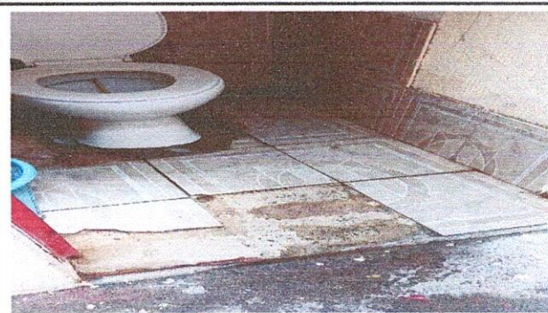
FOTO 14: 13.1 SUSTITUCIÓN DE AZULEJO
