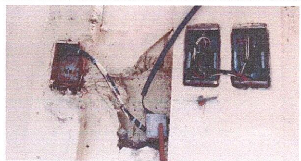
Foto 10: SUSTITUCION DE SISTEMA ELECTRICO
