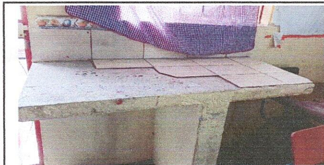
FOTO 13: 20.8 REPARACION DE AZULEJOS EN MUEBLES DE COCINA
