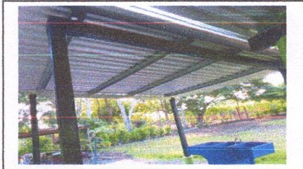
Foto 2: Estructura reconstruida, Renglón 2.1
