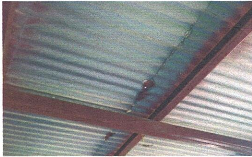
Foto 1: Lamina en mal estado, Region 1.1 (Sustitucion de lamina por lamina troquelada aluzinc calibre 26). Region 19.8 (Instalación de lamina troquelada aluzinc). Region 19.10 (Desinstalación de lamina existente).
