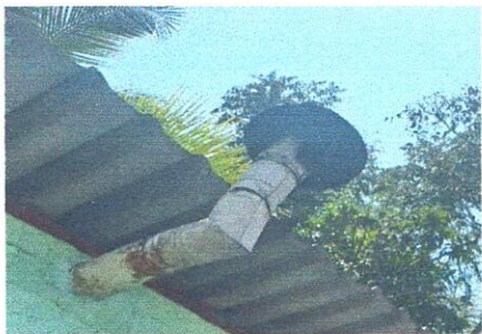
Foto 5: Chimenea en mal estado, Region 20.6 (Sustitución de chimenea de metal).
