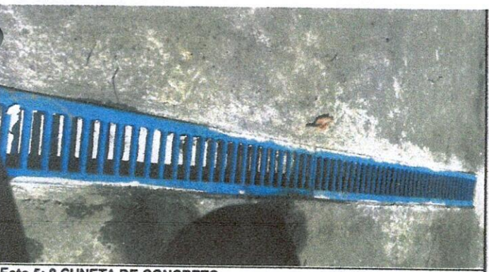
Foto 5: 8 CUNETETA DE CONCRETO
