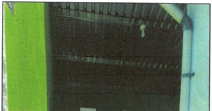
Foto 12: 17 REPARACIÓN DE SISTEMA ELÉCTRICO
