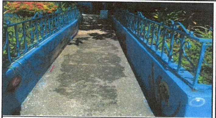
Foto 8: 11 MANTENIMIENTO A BARANDAS
