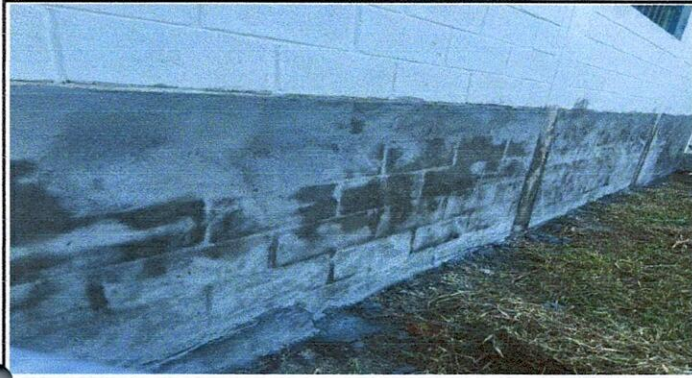
Foto13: 21 REPARACIÓN DE REPELLO Y CERNIDO DE PAREDES (CUANDO APLIQUE)
