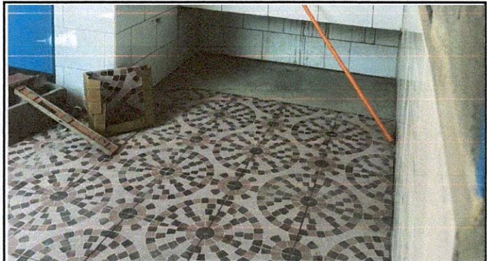
Foto 4: 6 PISO 6.8 SUSTITUCIÓN DE PISO CERÁMICO
