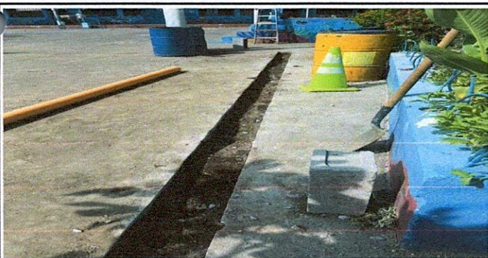
Foto 5: 8 CUNETETA DE CONCRETO
