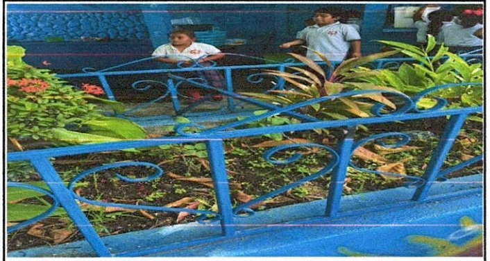
Foto 8: 11 MANTENIMIENTO A BARANDAS
