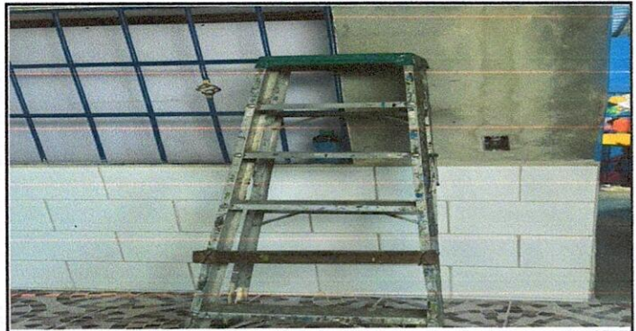
Foto 12: 17 REPARACIÓN DE SISTEMA ELÉCTRICO
