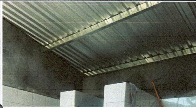
Foto 1: CUBIERTA DE LÁMINA. 2 ESTRUCTURA DE TECHO
