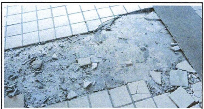
Foto 4: 6 PISO 6.8 SUSTITUCIÓN DE PISO CERÁMICO
