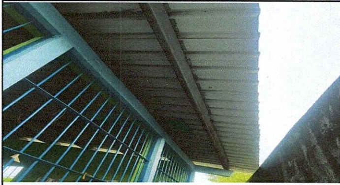
Foto 1: 1 CUBIERTA DE LÁMINA. 2 ESTRUCTURA DE TECHO.
