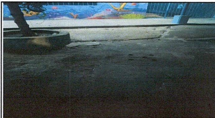
Foto 3: 6 PISO 6.5 SUSTITUCIÓN DE PISO DE TORTA DE CONCRETO
