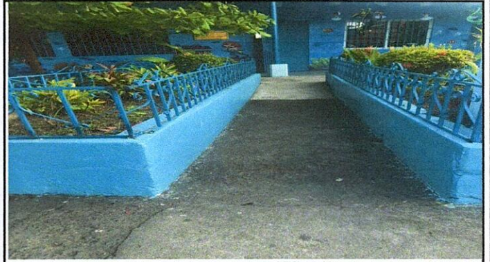
Foto 8: 11 MANTENIMIENTO A BARANDAS.
