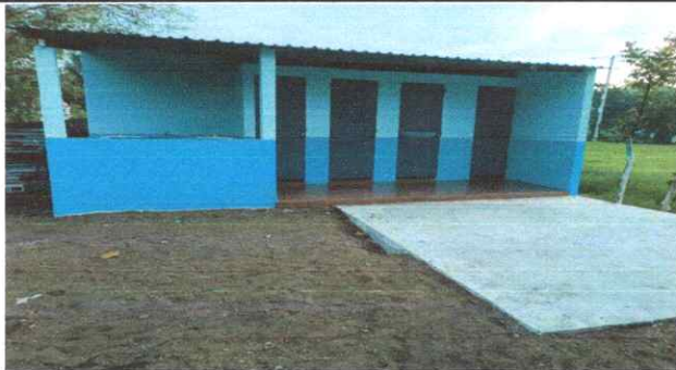
Foto 3: Sustitución de servicios sanitarios y sus accesorios
