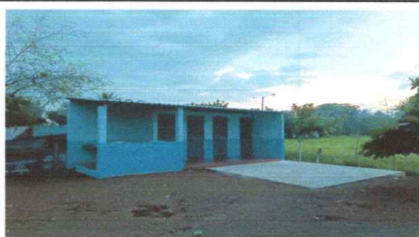
Foto 4: Sustitución de pila y colocación de labamanos
