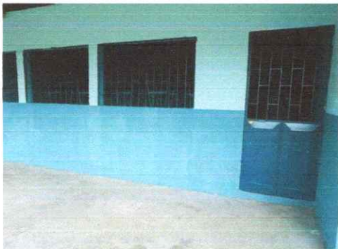
Foto1: Sustitución de Balcones
