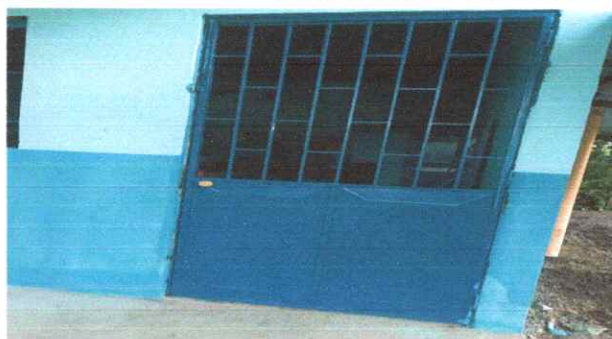
Foto 2: Sustitución de Puertas
