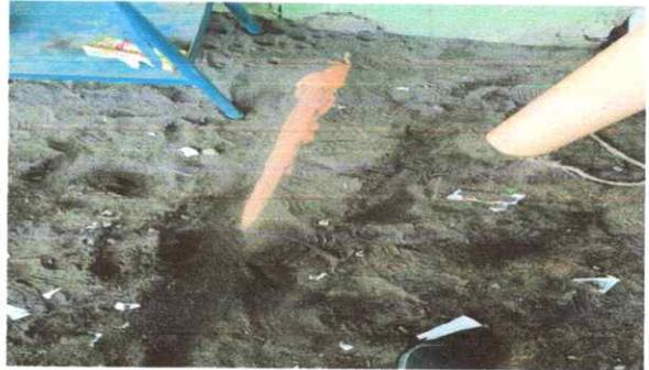
Foto 4: Sustitución de tubería PVC
