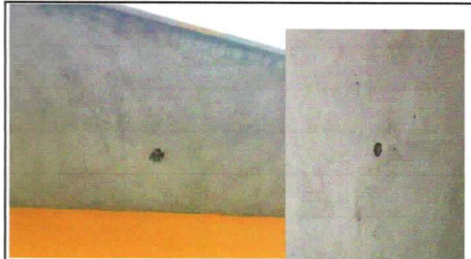
19.11 Instalación de unidades de luz (Incluye interruptor, ducto y cable eléctrico) 19.13 Instalación de tablero y flipones
