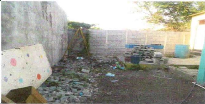
6.8 Sustitución de piso cerámico 9.1 Pintura en muros exteriores e interiores 13.1 Sustitución de azulejo
