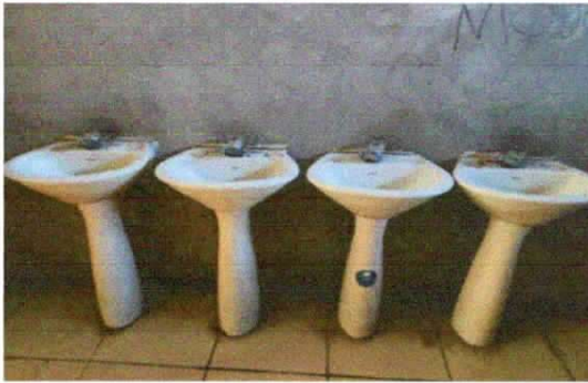
10.4 sustitución de mezcladora de lavamanos (contra llave, tubo de abasto)
