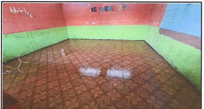
Foto 4: Instalación del piso cerámico en el salón de 2 C. Renglón 6.8 (Sustitución de piso cerámico).
