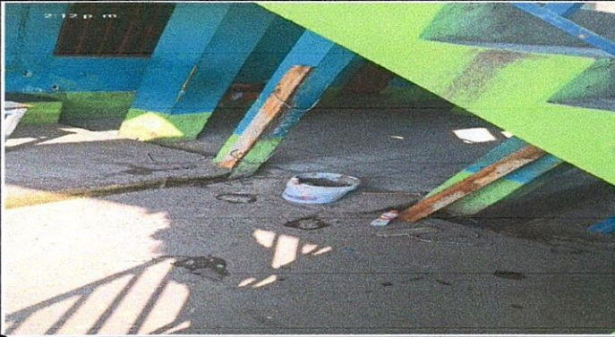
Foto 1: Mantenimiento de columna de concreto en mal estado.
