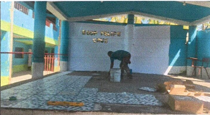
Foto 3: Extracción de residuos del piso de torta y continuación con la colocación del piso cerámico. Renglón 6.8 (Sustitución de piso cerámico).
