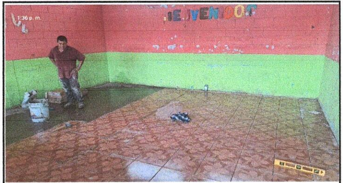
Foto 4: Colocación del piso cerámico en el aula de 2 B. Renglón 6.8 (Sustitución de piso cerámico).
