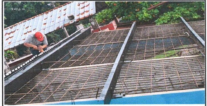
Foto 6: Colocación de capote en lámina troquelada. Renglón 1.2 (Sustitución de capote de lámina para lámina troquelada).
