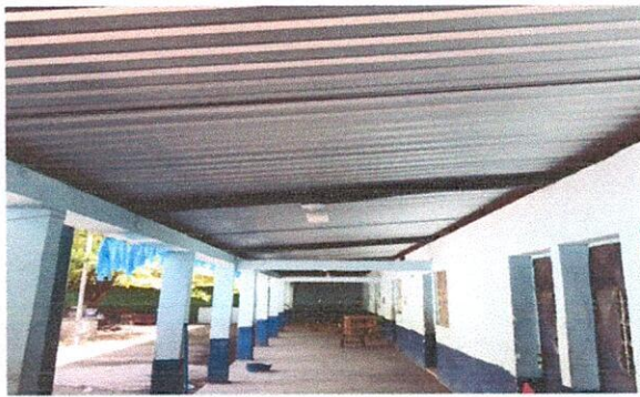
Foto 3: proyecto finalizado instalación de lámina troquelada
