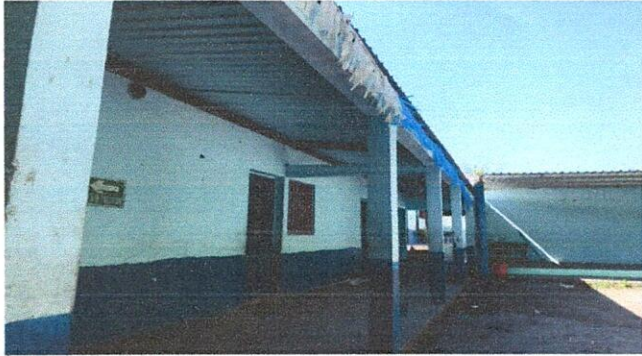
Foto 1: Proyecto finalizado sustitución del lámina por lámina troquelada
