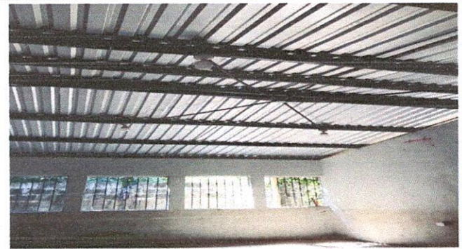
Foto 4: proyecto finalizado instalación de cableado eléctrico
