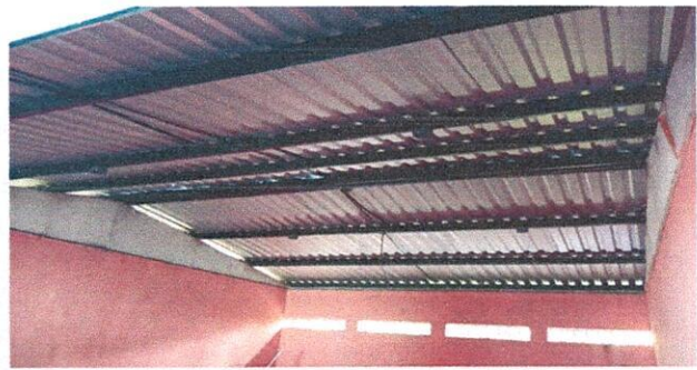
Foto 2: proyecto finalizado sustitución de capote para lámina troquelada
