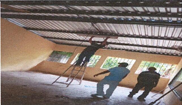
Foto 5: instalación de cableado eléctrico
