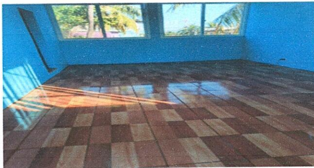
Foto 5: 6.8 SUSTITUCION DE PISO CERAMICO
