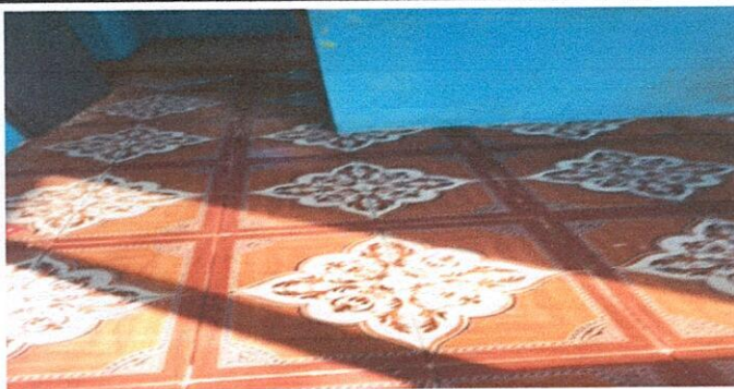
Foto 5: 6.8 SUSTITUCION DE PISO CERAMICO
