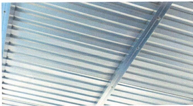
Foto 3: SUSTITUCION DE LAMINA POR LAMINA TROQUELDA ALAZINC CALIBRE 26
