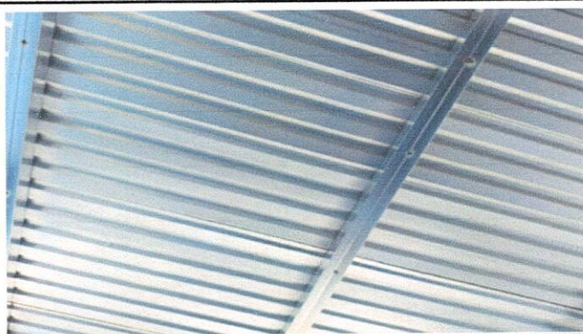
Foto 3: 1.1 SUSTITUCION DE LAMINA POR LAMINA TROQUELADA ALUZINC CALIBRE 26
