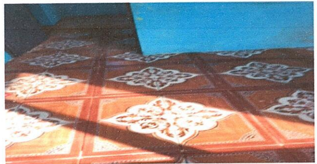
Foto 6: 6.8 SUSTITUCION DE PISO CERAMICO
