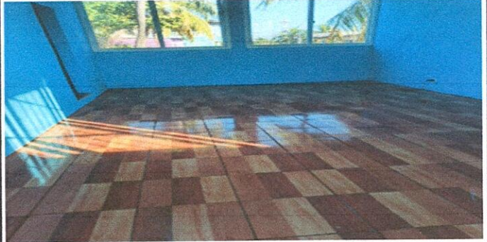
Foto 6: 6.8 SUSTITUCION DE PISO CERAMICO
