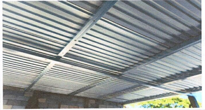
Foto 4: 2.3 SUSTITUCION DE ESTRUCTURA DE METAL POR METAL
