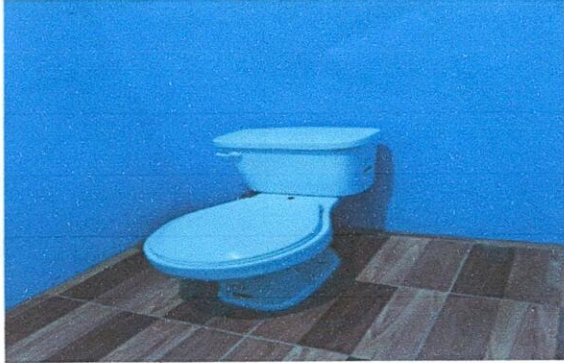
Foto1: Sustitucion de sanitario
