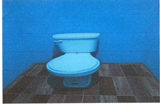
Foto 2: Sustitucion de sanitario
