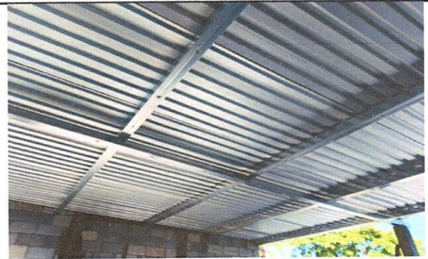
Foto 4: 2.3 SUSTITUCION DE ESTRUCTURA DE METAL POR METAL
