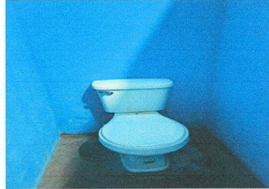
Foto 2: 10.2 SUSTITUCION DE ACCESORIOS DE INODORO
