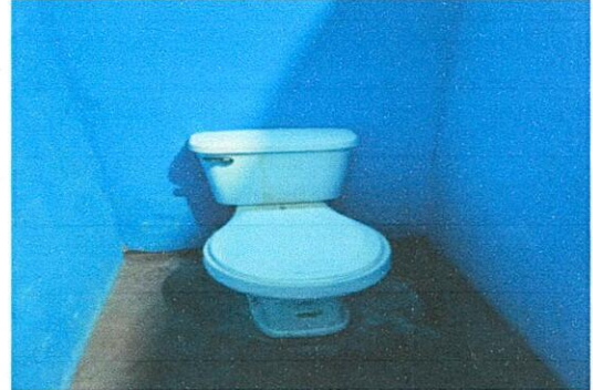
Foto 2: Sustitucion de sanitario
