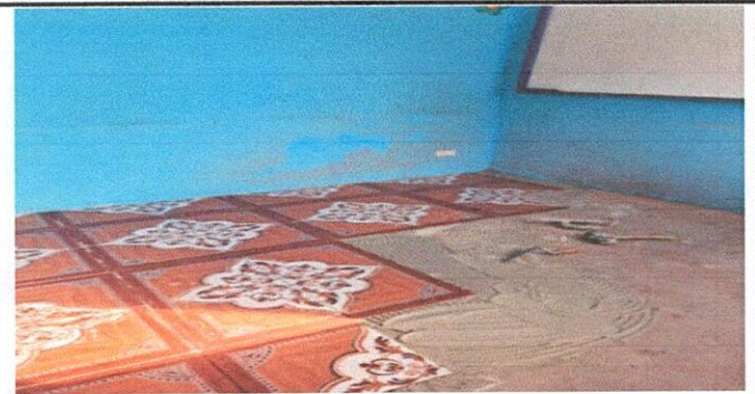
Foto 6: 6.8 SUSTITUCION DE PISO CERAMICO
