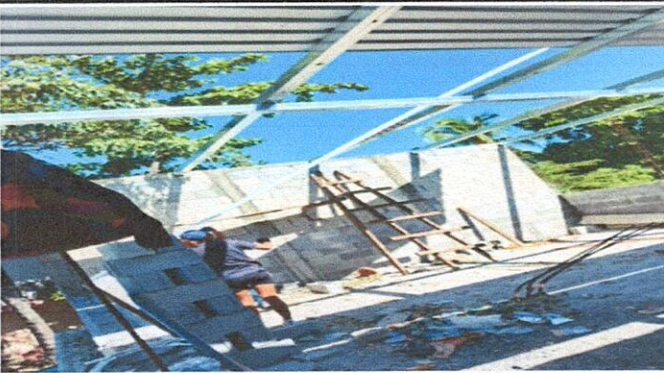
Foto 3: 1.1 SUSTITUCION DE LAMINA POR LAMINA TROQUELDA ALAZINC CALIBRE 26
