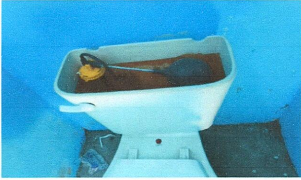
Foto1: Sustitucion de sanitario
