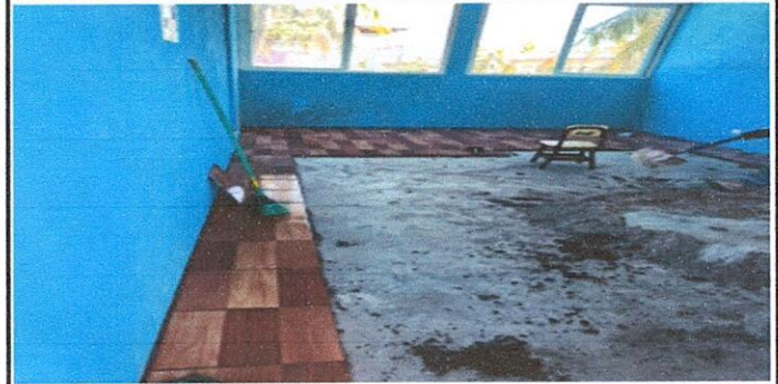
Foto 6: 6.8 SUSTITUCION DE PISO CERAMICO
