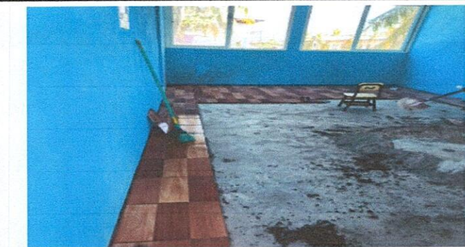
Foto 5: 6.8 SUSTITUCION DE PISO CERAMICO
