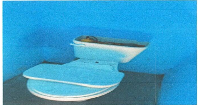
Foto 2: Sustitucion de sanitario
