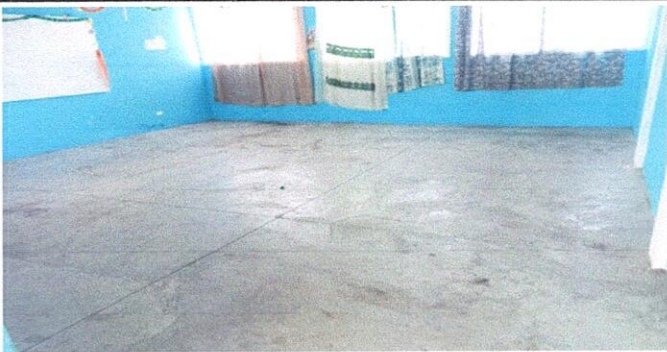
Foto 5: Sustitucion de piso ceramico
