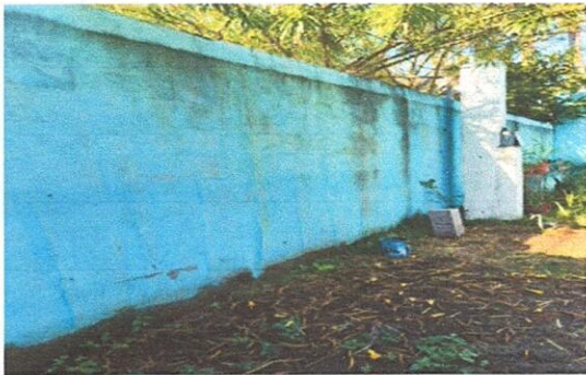
Foto 3: Pintura en muro exterior e interior
