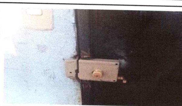
Foto 4: Instalación de chapas. 4.2
