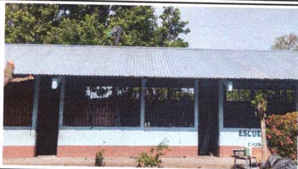
Foto 1: Lámina ya instalada. Renglón 1.1. 1.2. 1.3
