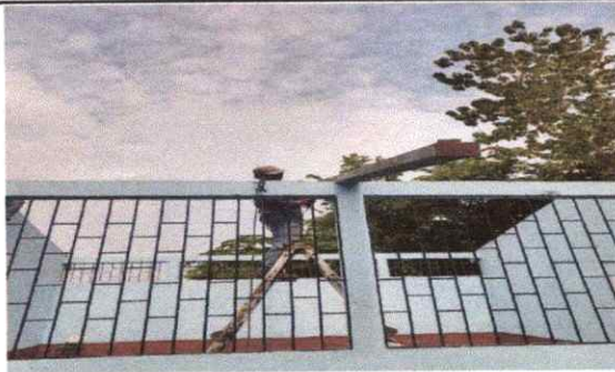
Foto 1: Desinstalación de la lámina. Renglón 1.1. 1.2. 1.3
