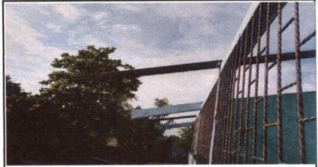
Foto 2: Desinstalación de las costaneras. 2.3
