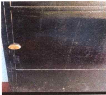
Foto 3: Proceso de mejora de la puerta. 4
