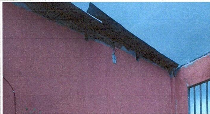
Foto 4: SUSTITUCIÓN DE DUCTO ELÉCTRICO
