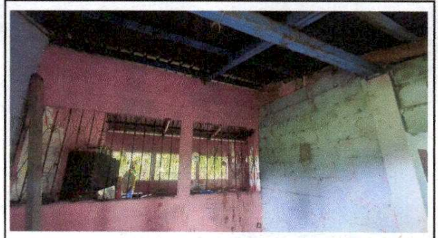
Foto 8: Pared interna entre aulas
