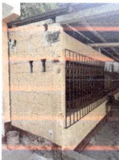
Foto 5: MUROS DAÑADOS Y ESPACIOS LIBRES ENTRE MURO Y ESTRUCTURA, GENERA INGRESO A ROEDORES
