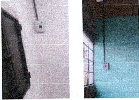
Foto13: Instalación de tablero y flipones
