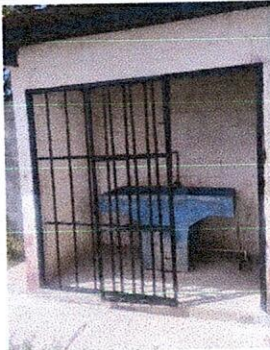
Foto:17 Instalacion de puerta de rejas.
