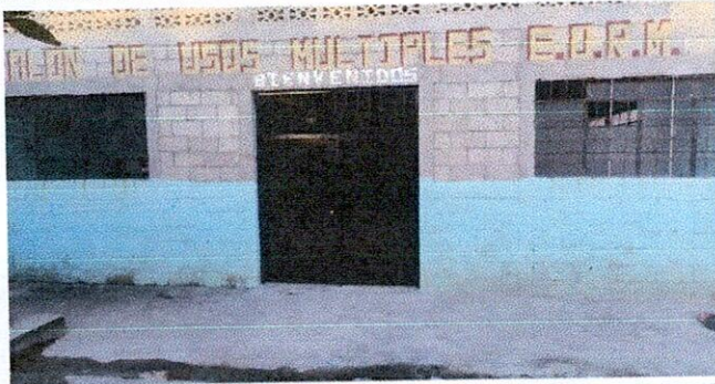
Foto 5: Sustitución de portón de metal.
