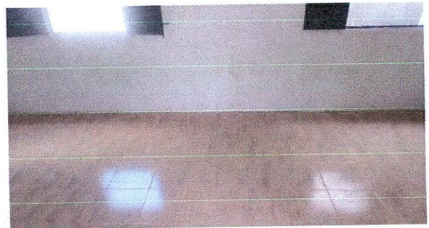
Foto 6: Reparación de piso cerámico
