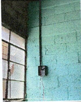
Foto13: Instalación de tablero y flipones
