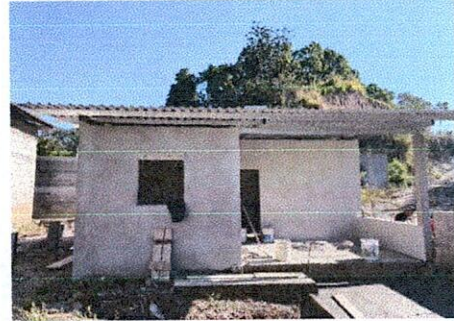
Foto 2: Sustitución de estructura de soporte de metal, por metal
