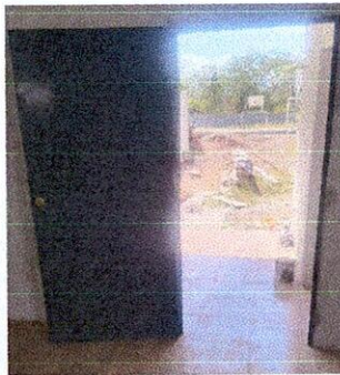
Foto 3: Sustitución de puerta
