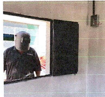
Foto 4: piso: Sustitución de ventanas de madera por metal
