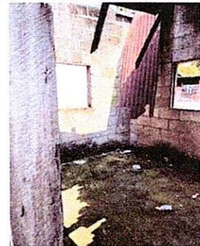
Foto 4: piso: Sustitución de ventanas de madera por metal
