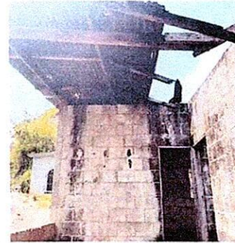
Foto 2: Sustitución de estructura de soporte de metal, por metal
