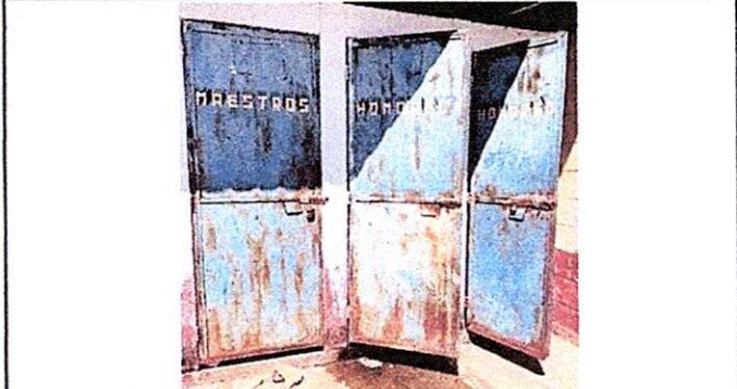
Foto 8: Mantenimiento a estructura (lijado, cambio de tubo , cepillado, sujeciones, aplicación de pintura)
