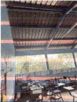
Foto 3: LAS LAMINAS PRESENTAN OXIDO Y RAJADURAS AL IGUAL QUE LAS COSTANERAS YA PRESENTAN CORROSIÓN
