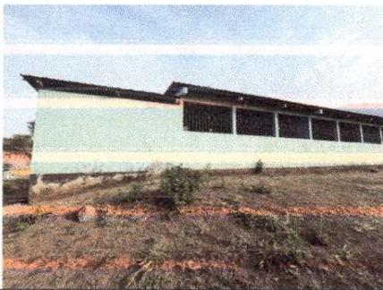
Foto 5: REPELLO Y PINTURA EN MAL ESTADO
