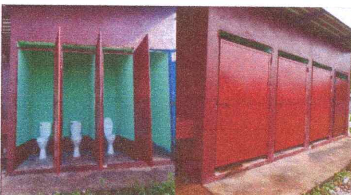
Foto 7, 8: sustitución de puertas en servicios sanitarios
