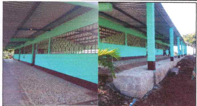
Foto 27 y 28: aplicación de pintura en paredes
