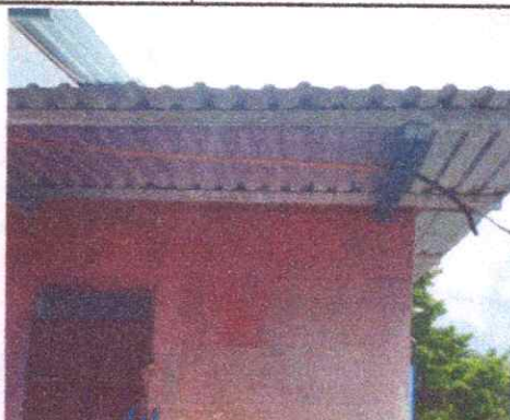
Foto 3: sustitución de estructura de soporte de metal por metal
