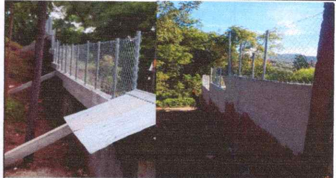
Foto 15 y 16: reparación de muro perimetral de block y reparación de tubo hg malla garbanizad
