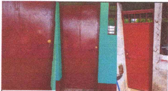
Foto 4, 5 y 6: sustitucion de tres chapas
