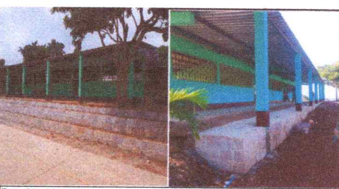
Foto 11 y 12: reparación de banqueta de concreto
