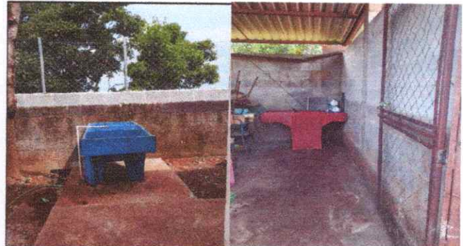
Foto 19 y 20: sustitución de dos pilas de cemento de dos lavadero
