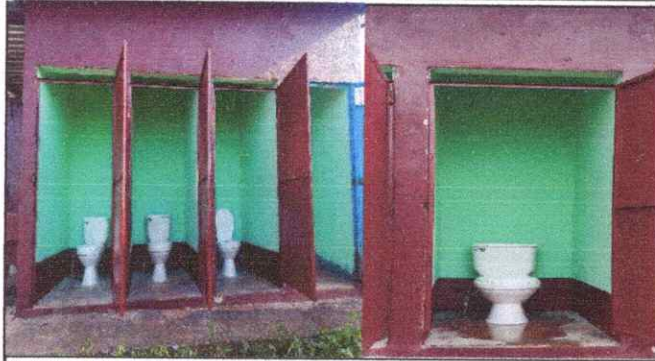
Foto13 y 14: sustitución de inodoro
