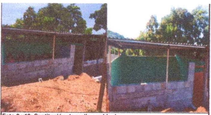
Foto 9 y10: Sustitución de malla por block
