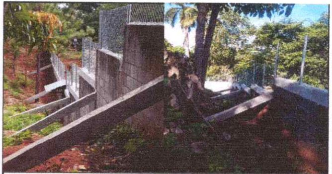
Foto 23 y24: Reparación de muro de contención en todo alrededor del establecimiento
