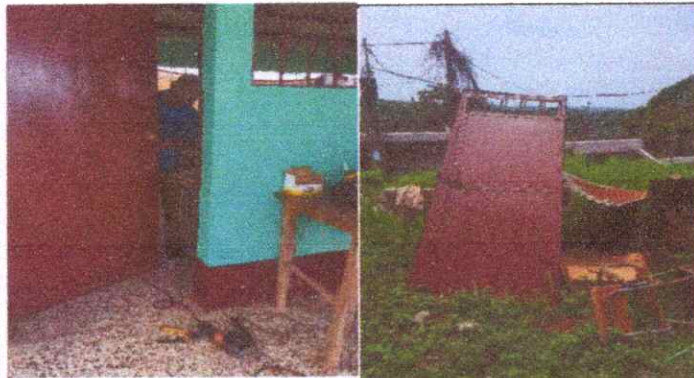
Foto 4 Y 5: Sustitución de tres chapas y sustitución de puertas en servicios sanitarios
