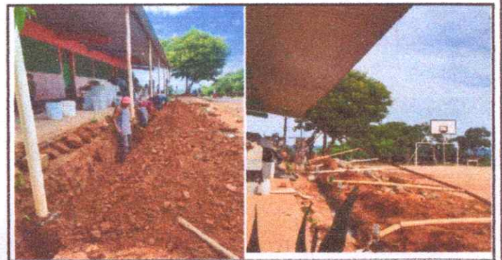
Foto 10 Y 11: Reparación de banqueta de concreto
