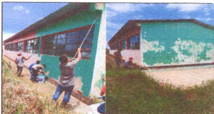
Foto 33 y 34: aplicación de pintura en las aulas
