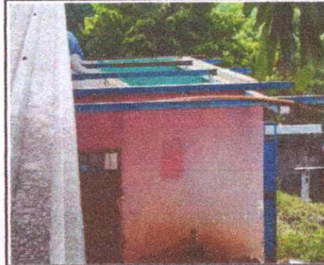
Foto 3: Sustitución de estructura de metal por metal
