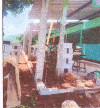
Foto 14: Reparación de banqueta de concreto
