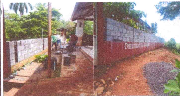
Foto 21 y 22: reparacion de muro perimetral de block y reparación de tubo hg galvanizado
