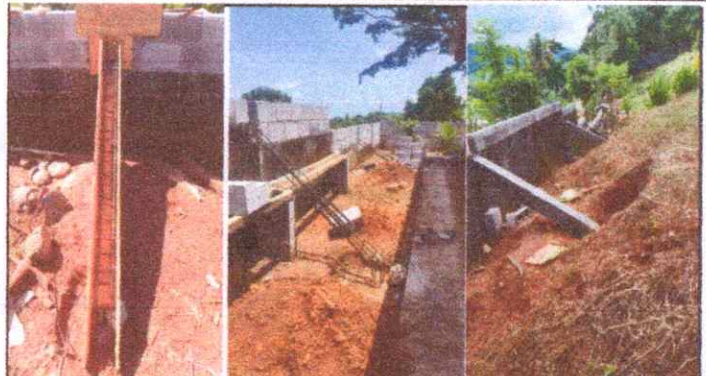
Foto 28, 29 y 30: Reparación de muro de contención en todo alrededor del Establecimiento
