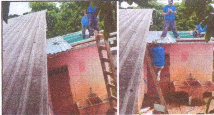
Foto 1 y 2: Sustitución de lámina por lámina troquelada aluzinc calibre26
