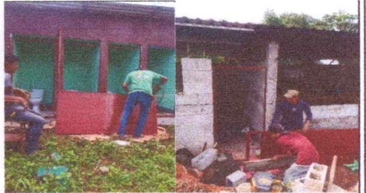
Foto 6 Y 7: Sustitución de puertas
