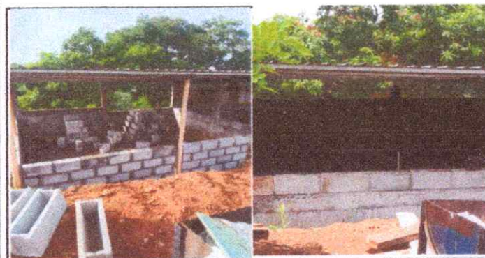
Foto 8 Y 9: Sustitución de malla por block
