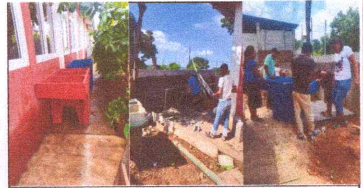
Foto 23, 24 y 25: sustitución de dos pilas de cemento de dos lavadero
