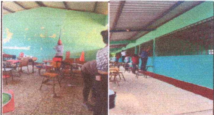
Foto 31 y 32: aplicación de pintura en las paredes de las aulas
