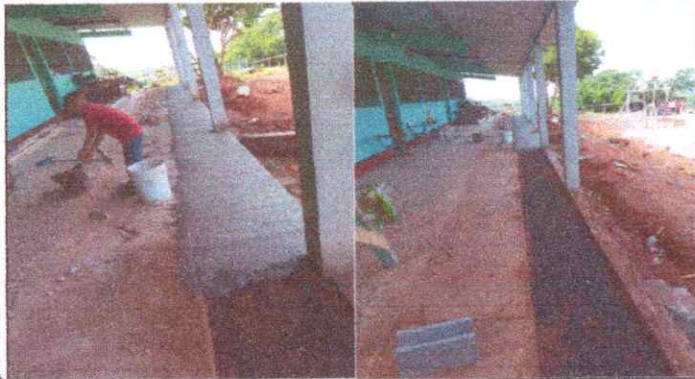
Foto 12 Y 13: Reparación de banqueta de concreto
