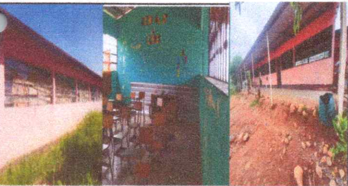
Foto 17, 18 y 19 aplicación de pintura en paredes
