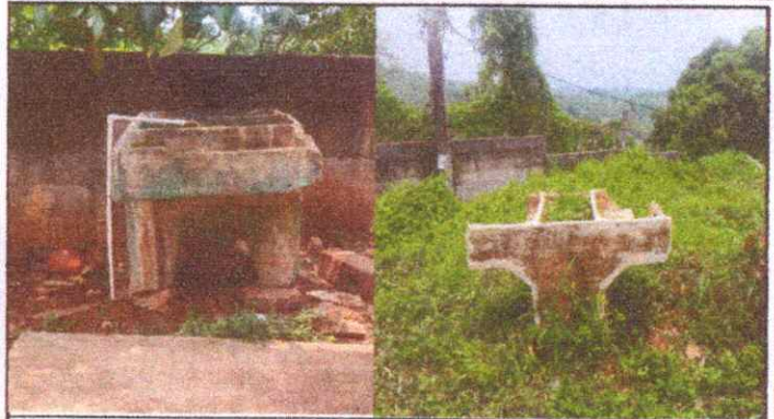
Foto 12 y 13: sustitución de dos pilas de cemento dos lavadero
