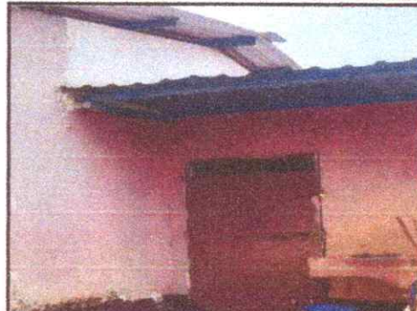
Foto 2: Sustrucción de estructura de soporte de metal por metal
