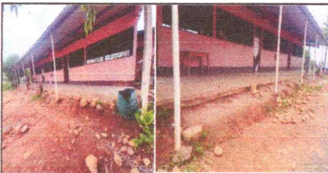
Foto 6 y 7: reparación de banqueta de concreto
