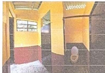
Foto 4: SUMINISTRO E INSTALACIÓN DE INODORO, SUMINISTRO E INSTALACIÓN DE PUERTA CON PASADOR, APLICACIÓN DE PINTURA, SUMINISTRO E INSTALACIÓN DE ESTRUCTURA PORTANTE, SUMINISTRO E INSTALACIÓN DE LÁMINA TROQUELADA
