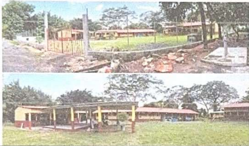
Foto 1: REMOZAMIENTO DE MURO PERIMETRAL, VISTA PANORÁMICA DE ESTABLECIMIENTO
