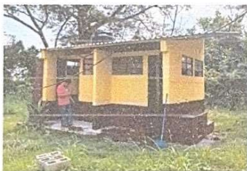
Foto 3: APLICACIÓN DE PINTURA, SUMINISTRO E INSTALACIÓN DE ESTRUCTURA PORTANTE, SUMINISTRO E INSTALACIÓN DE LÁMINA TROQUELADA
