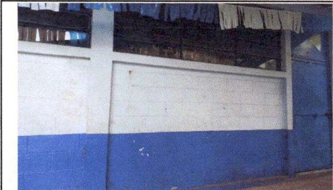
Foto 9: Modulo de aulas
