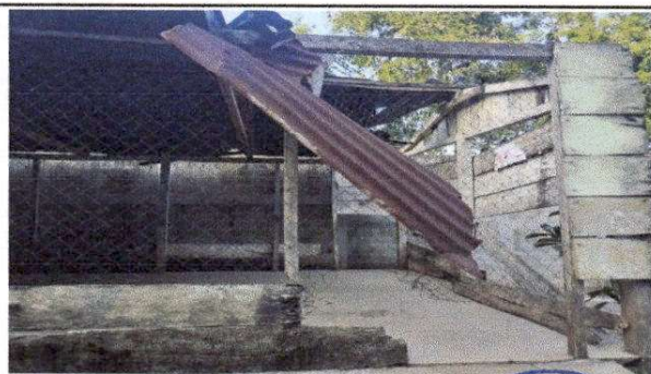
Foto 5: Aula con galera provisional
