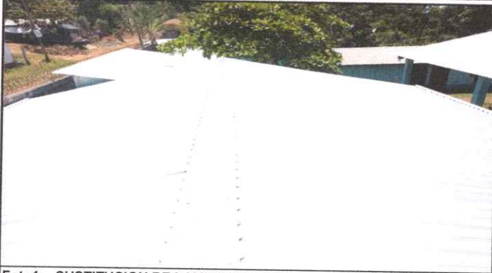
Foto1: SUSTITUCION DE LAMINA TROQUELADA ALUZINC CALIBRE 26 DE 1 AULA BAÑOS HOMBRES-MUJERES Y LA DIRECCION.
