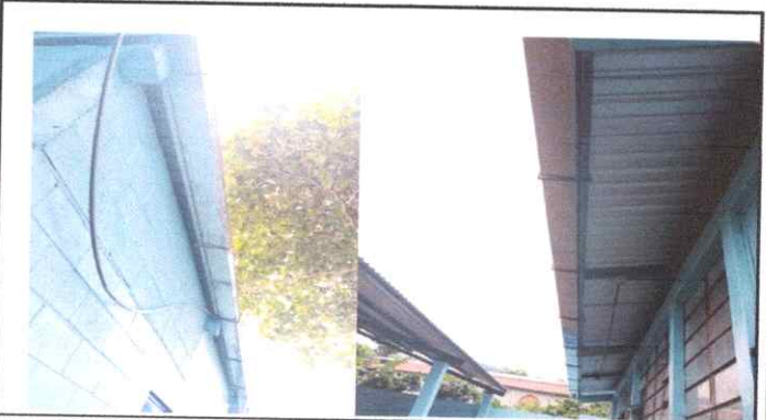
Foto 4: SUSTITUCION DE CANAL DE METAL
