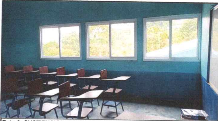
Foto 3: SUSTITUCION DE ESTRUCTURA DE METAL DE VENTANAS
