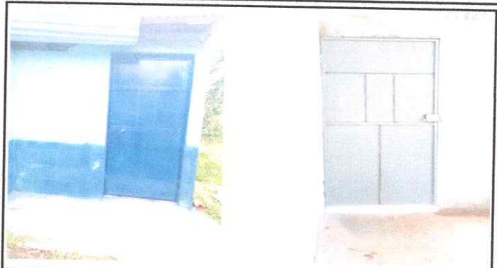
Foto 2: SUSTITUCION DE PUERTA DE METAL PARA COCINA
