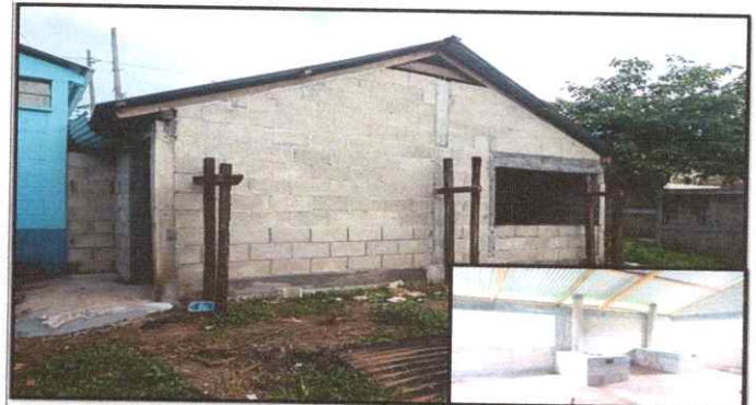
Foto REPARACION DE MURO PERIMETRAL DE BLOCK Y SUSTITUCION DE ESTUFA RURAL COMPLETA, INCLUYE CHIMINEA Y PLANCHA DE CONCRETO.
