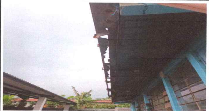
Foto 4: SUSTITUCION DE CANAL DE METAL
