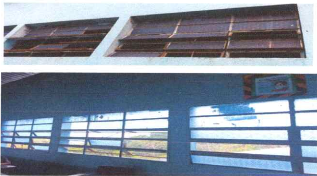
Foto 3: SUSTITUCION DE ESTRUCTURA DE METAL DE VENTANAS
