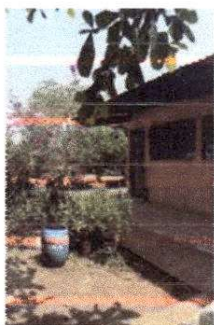
Foto 11: PINTURA DAÑADA, NO CUENTA CON CANAL NI BAJADA DE AGUA PLUVIAL
