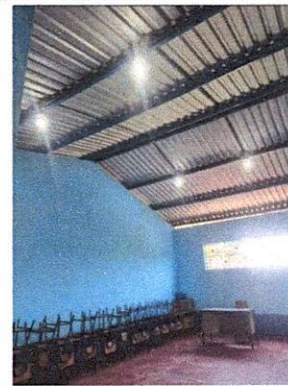
Foto 4: Pintura de muros interiores y exteriores
