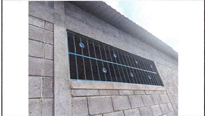
Foto 4: Sustitución de balcones de metal
