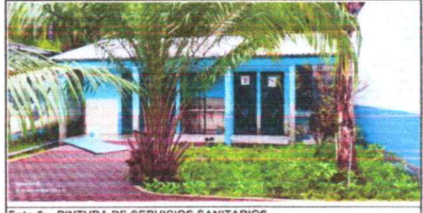
Foto 6: PINTURA DE SERVICIOS SANITARIOS
