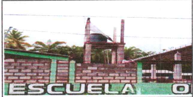
FOTO 3: CONSTRUCCIÓN DE MURO PERIMETRAL 30%
