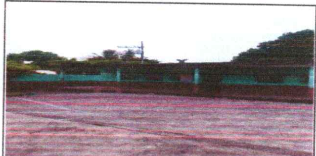
INICIO DE SUSTITUCIÓN DE LAMINA TROQUELADA 10%
