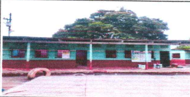
INICIO DE SUSTITUCIÓN SOPORTE DE MADERA A SOPORTE DE METAL 10 %
