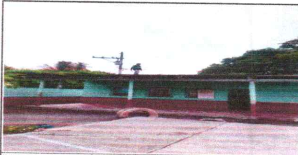
INICIO DE SUSTITUCIÓN DE LAMINA TROQUELADA 10%
