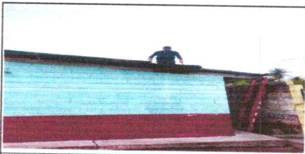
INICIO DE SUSTITUCIÓN DE LAMINA TROQUELADA 10%
