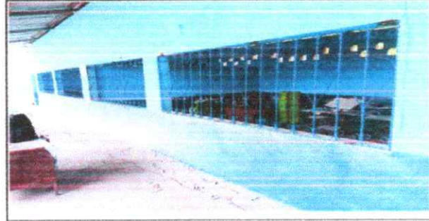
FOTO 4: SUSTITUCIÓN DE BALCONES DE METAL 100%
