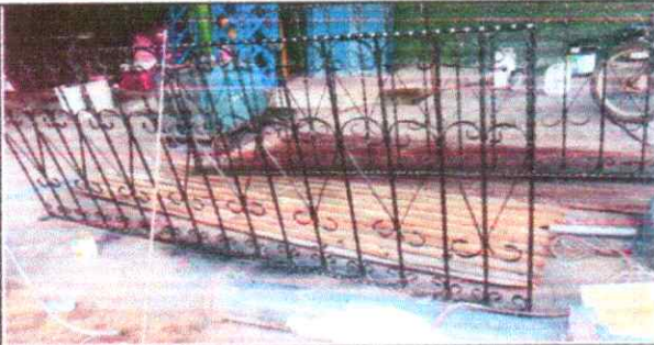
FOTO 3: SUSTITUCIÓN DE BALCONES DE METAL
