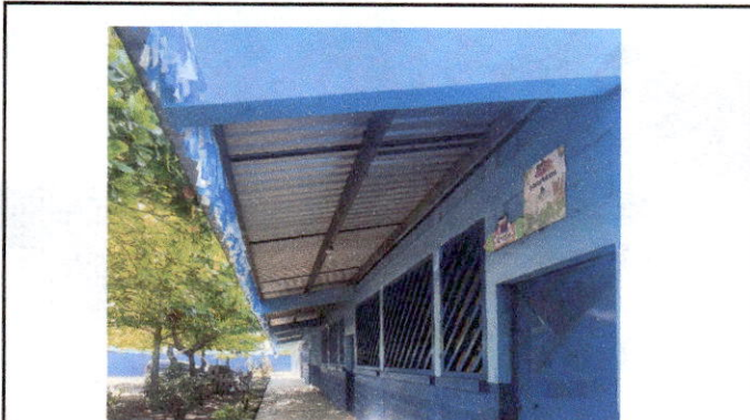
Foto 3: Techo de pasillos
