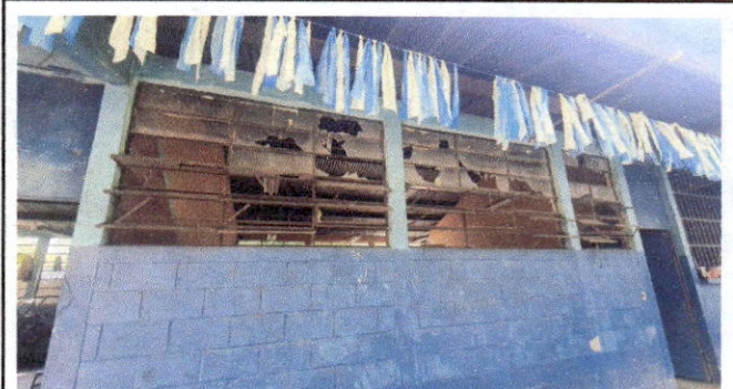
Foto 12: Ventanas en aulas
