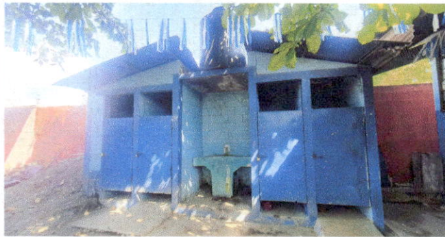
Foto 9: Modulo de baños y pila
