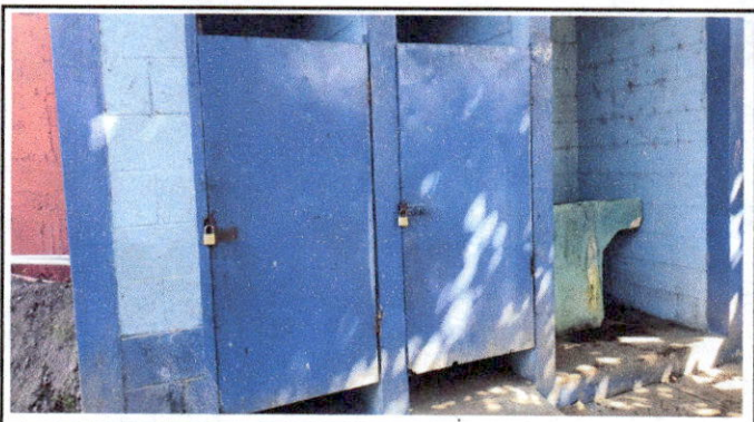
Foto 5: Modulo de baños
