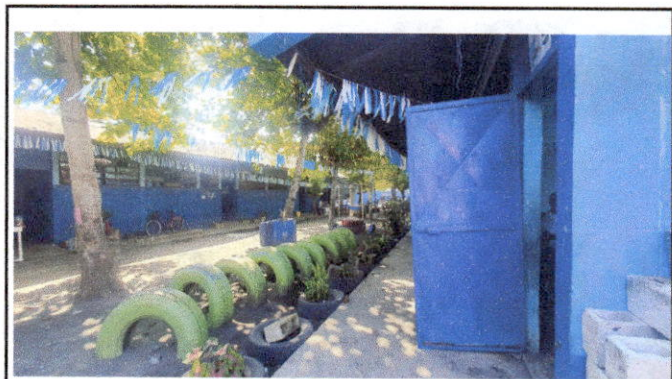
Foto 4: Patio y modulos de aulas
