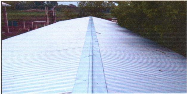
FOTO 3: FINALIZACIÓN DE SUSTITUCION DE LAMINA TROQUELADA
