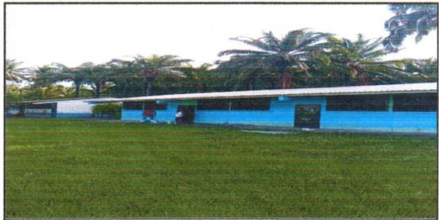
Foto 6: FINALIZACIÓN DE SUSTITUCION DE LAMINA TROQUELADA
