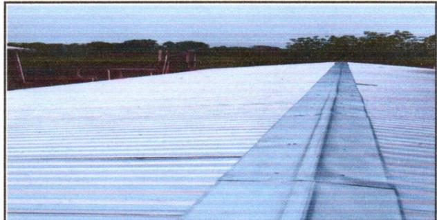
Foto 4: FINALIZACIÓN DE SUSTITUCION DE LAMINA TROQUELADA
