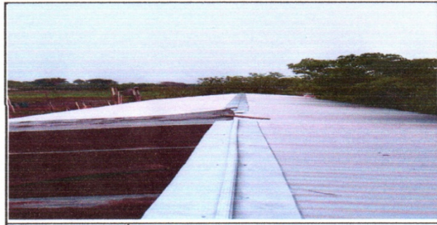
Foto 6: INSTALACIÓN DE LAMINA TROQUELADA
