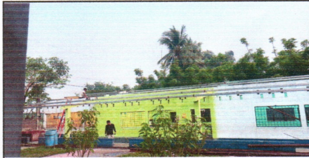
FOTO 1: SUSTITUCIÓN DE SOPORTE DE METAL POR METAL
