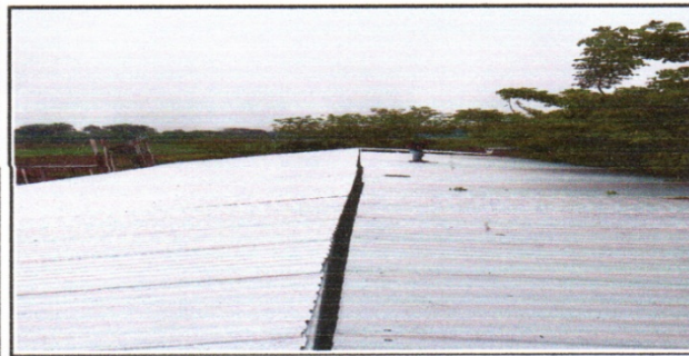
Foto 5: INSTALACIÓN DE LAMINA TROQUELADA
