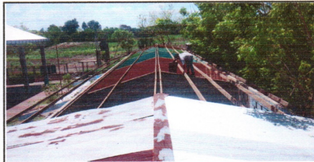
FOTO 3: INSTALACIÓN DE SOPORTE DE METAL
