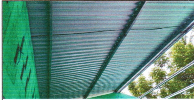
Foto 4: INSTALACION DE LAMINA TROQUELADA
