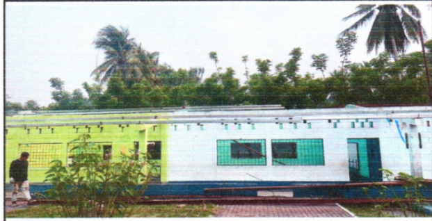
FOTO 2: SUSTITUCIÓN DE SOPORTE DE METAL POR METAL
