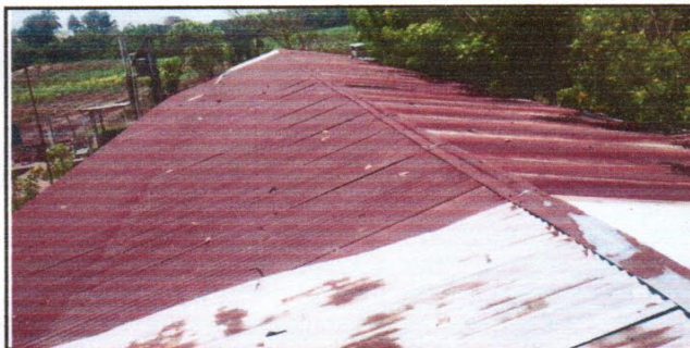
Foto 5: DESINTALACIÓN DE ESTRUCTURA EXISTENTE
