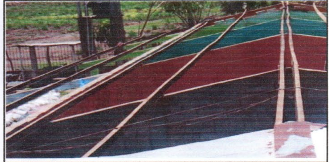
FOTO 2: SUSTITUCIÓN DE SOPORTE DE METAL POR METAL
