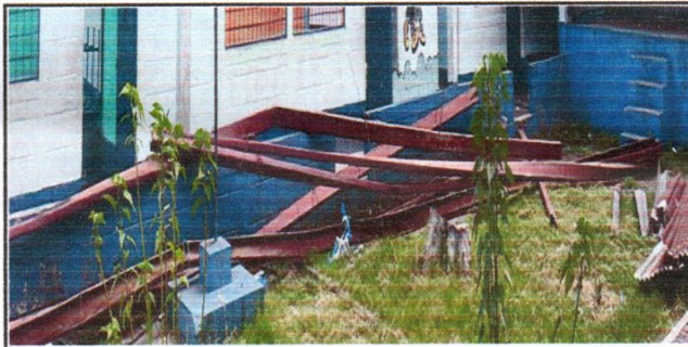
FOTO 3: SUSTITUCIÓN DE SOPORTE DE METAL POR METAL
